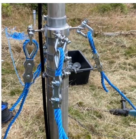
Ab vier Meter Höhe muss der Mast verspannt werden. Der Abspannkranz wird in Bodennähe montiert und dann beim Ausziehen des Teleskopmastes in die Höhe geschoben.
